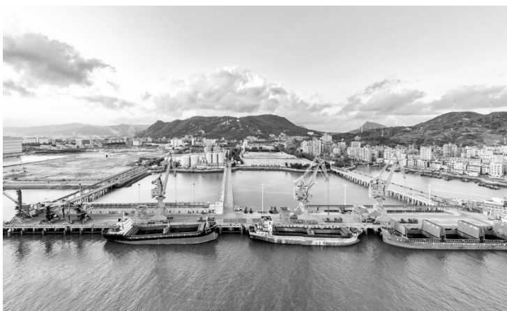
▲福清松下港区元洪作业区 (来源:福州新闻网)
